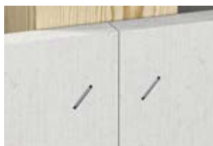
Plattenstoß dicht gestoßen, Fugenbreite ≤ 1 mm
