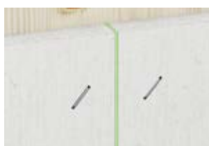
fermacell™ Klebefuge, Fugenbreite ≤ 1 mm
