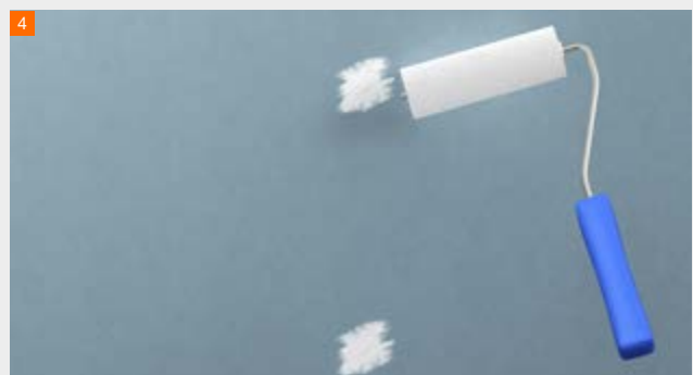
Deckendes Abtupfen der Verbindungsmittel in der Plattenfläche
