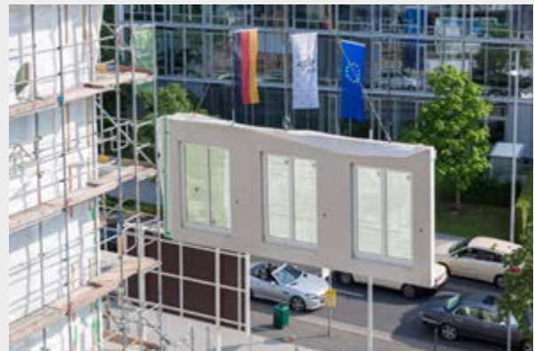
Krantransport auf der Baustelle
