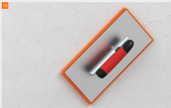
Abfilzen der Putzoberfläche mit einer Schwammscheibe
