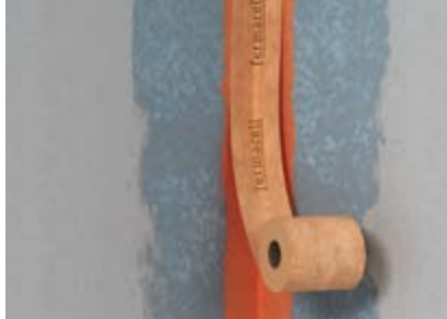
Abb. 2+3: fermacell™ Dichtband in die zuvor aufgetragene, noch feuchte fermacell™ Flüssigfolie drücken und direkt mit Flüssigfolie überstreichen – Trocknungszeit mind. 1 Stunde
