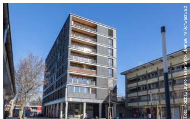
Gebäudeklasse 5 - Achtgeschossiger Holzbau - Wohn-/Gewerbebau Buggi 52
