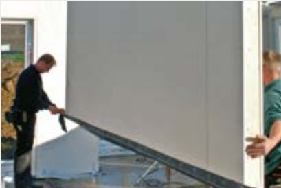
Positionieren, Ausrichten und Unterklotzen der Wandelemente
