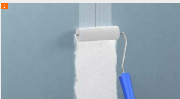
Aufrollen des fermacell™ Armierungsklebers HD
