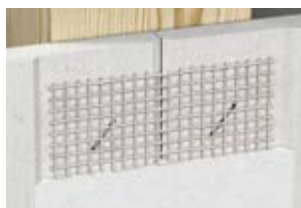
Trockenbaukante, Plattenstoß dicht gestoßen
