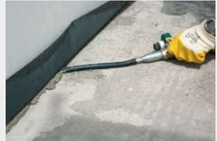
Maschinelles Verfüllen der Bauteilfuge
