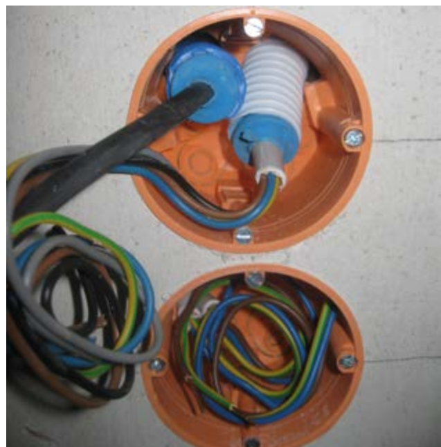
Beispiel: Abdichten der Leerrohre, die nach außen führen
