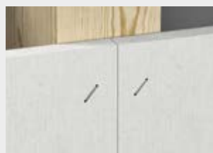
Platten stumpf gestoßen
