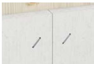
Plattenstoß dicht gestoßen, Fugenbreite ≤ 1 mm
