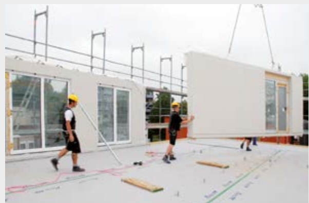
Montage auf der Baustelle
