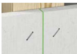
fermacell™ Klebefuge, Fugenbreite ≤ 1 mm
