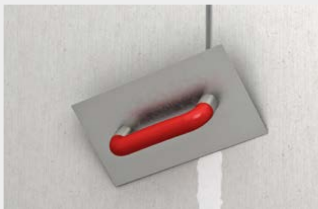
Spachteln von Fugen, entscheidend für Oberflächenqualitäten Q1 bis Q4
