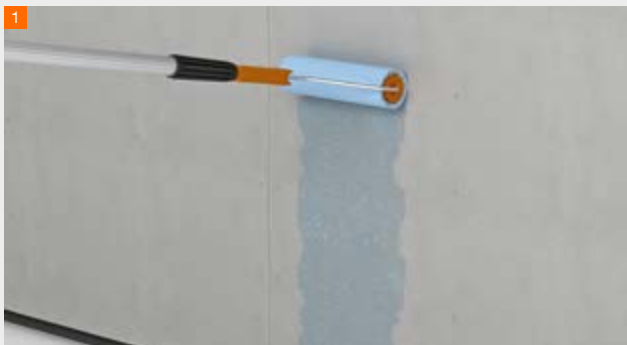
Grundierung mit fermacell™ Tiefengrund
