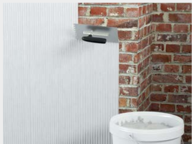
An Schornsteinwangen sind fermacell® Gipsfaserplatten vollflächig mit fermacell™ Ansetzbinder anzusetzen.
