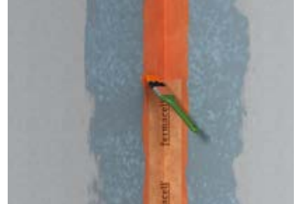
Abb. 2+3: fermacell™ Dichtband in die zuvor aufgetragene, noch feuchte fermacell™ Flüssigfolie drücken und direkt mit Flüssigfolie überstreichen – Trocknungszeit mind. 1 Stunde
