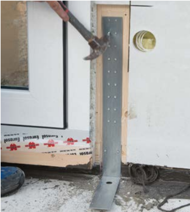
Montage Zuganker
