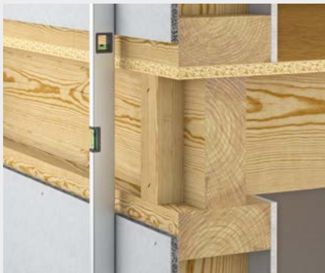
Bild 1: Ausrichten der Wandelemente
