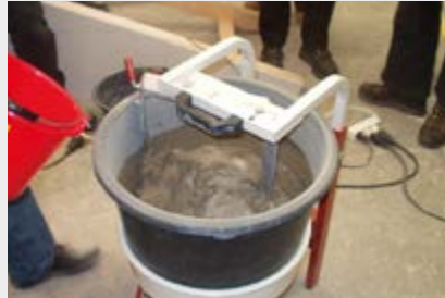
Anmischen fermacell™ Quellmörtel
