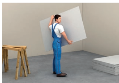
Einzelne fermacell® Gipsfaserplatten hochkant tragen
