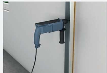
Befestigung der CW-Profile an Massivwand auf Dämmstreifen
