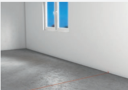
Anlegen der Wandachse mit Schnurschlag oder Hochbaulaser
