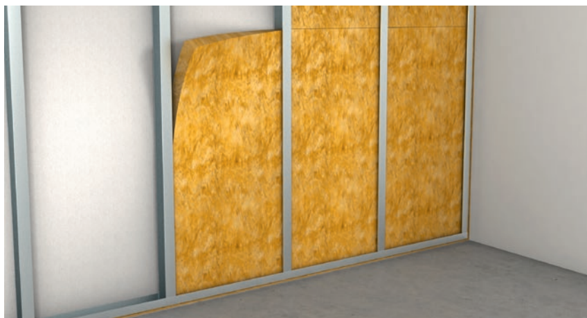
Einbringen der Dämmstoff-Platten
