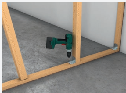
Montage der Holzständer mit Stiftnagel oder Stahlwinkel
