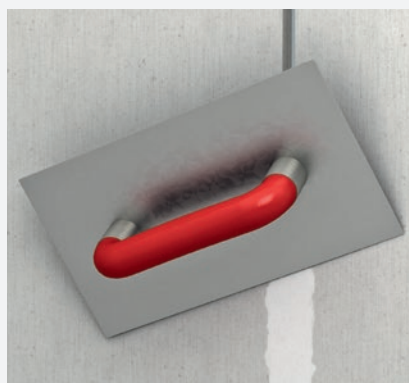
Fugen und Befestigungsmittel verspachteln
