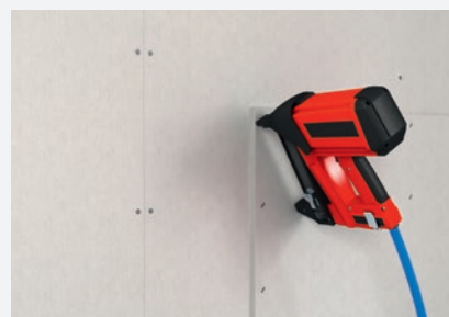
Klammern fermacell® Gipsfaserplatte auf fermacell® Gipsfaserplatte (unterkonstruktionsneutral)
