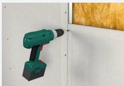
Schrauben auf Stahlunterkonstruktion
