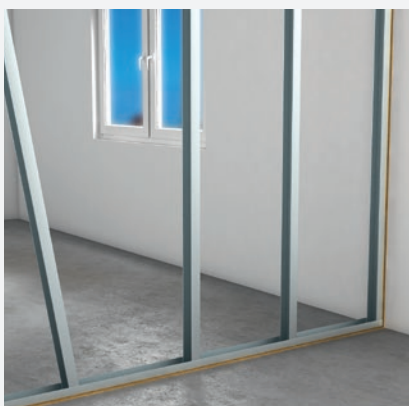
Montage der CW-Ständerprofile
