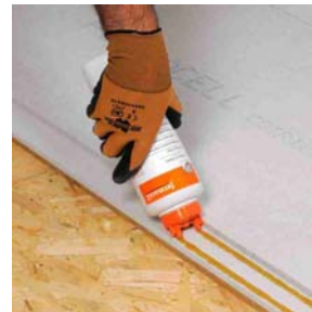
Auftragen des FERMACELL Estrich-Klebers im Falzbereich
