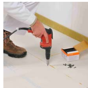
Befestigen durch Verschrauben...
