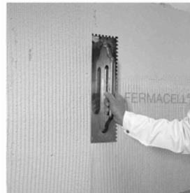
Eindrücken des FERMACELL Armierungsgewebes HD in das Mörtelbett
