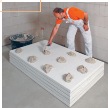
Ansetzbinder batzenförmig auf die Rückseite auftragen
