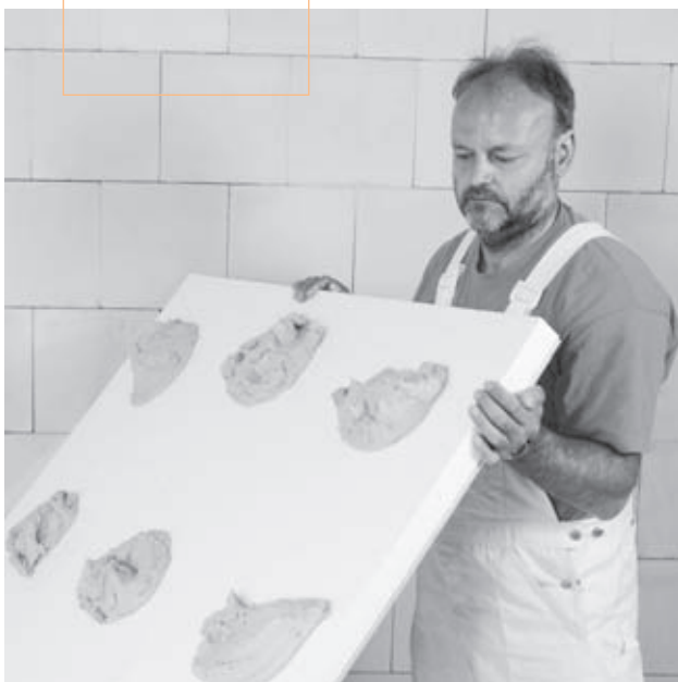
Die wärmedämmende FERMACELL Verbund-Platte. Im Format 150 x 100 cm. In vier verschiedenen Dicken lieferbar.
