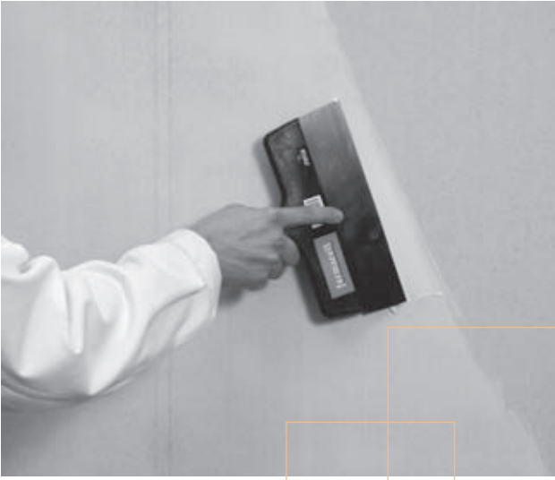
Flächenspachtelung von FERMACELL Gipsfaser-Platten
